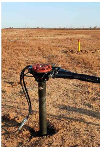
Гидровращатель (гидравлический сваекрут)
