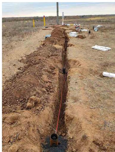
Установленное анодное заземление с использованием винтовых свай
