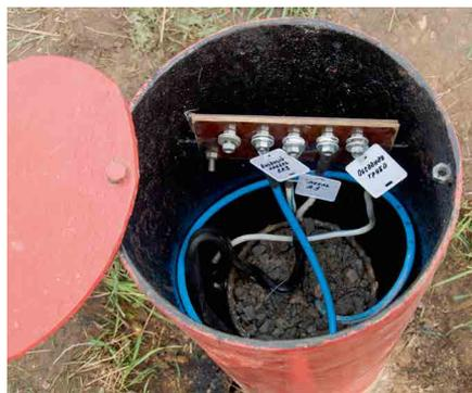
*Установка магнетитовых анодов и подключение кабелей к клеммной панели КИП*
